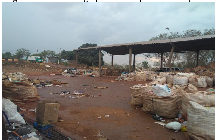
Figura 01. Vista do galpão da Cooperativa Coopermar
