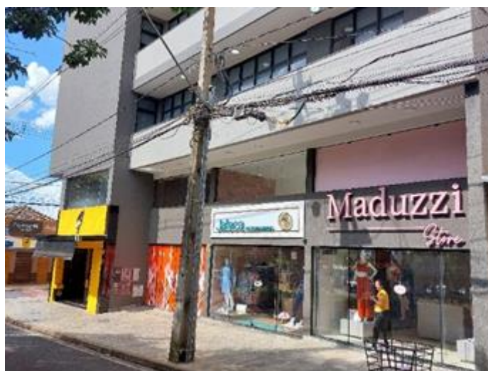
Figura 5: Galeria comercial e de serviços na Avenida Getúlio Guaritá, Uberaba/MG
