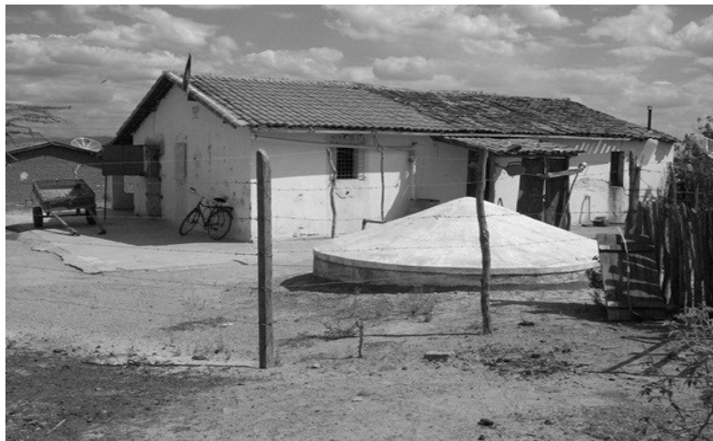
Foto 02: Cisterna de Placas utilizada para a captação da água de chuva.
