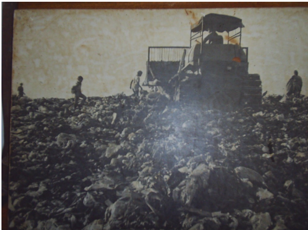
Figura 01: Compactação dos resíduos sólidos em células do Lixão da Zona Norte de Porto Alegre Fonte: Departamento Municipal de Limpeza Urbana, 1985.
