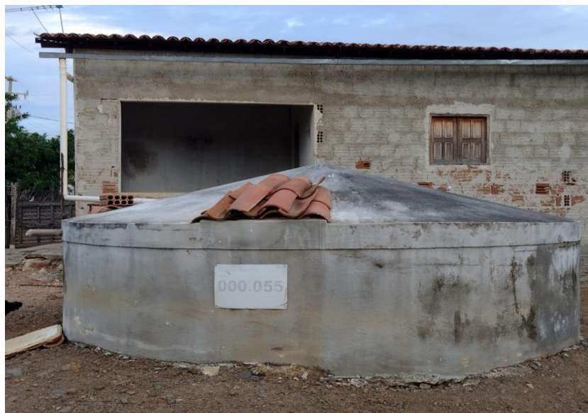
Figura 4 - Cisterna implementada pelo P1MC no Perímetro Irrigado Sabugi
