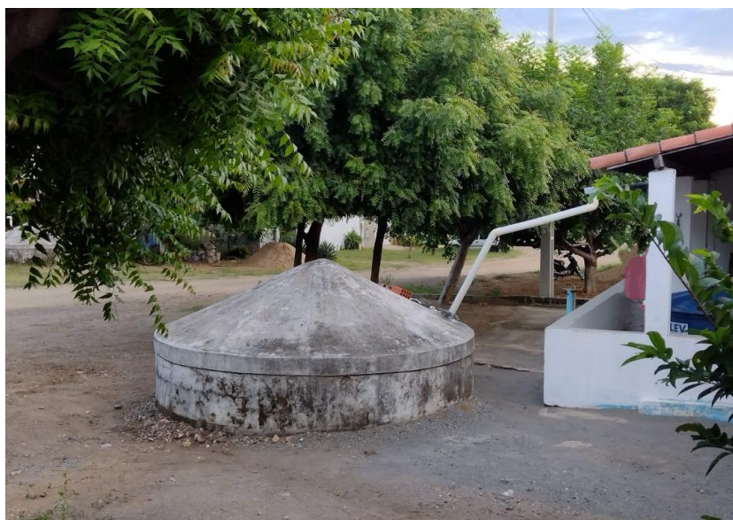
Figura 2 – Cisterna implementada pelo PCPR no Perímetro Irrigado Sabugi
