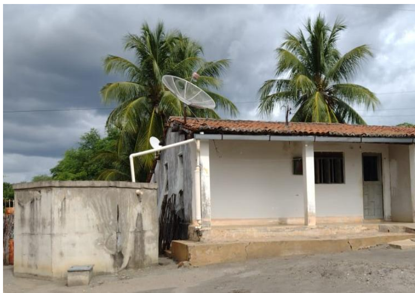
Figura 3 - Cisterna implementada pela Funasa no Perímetro Irrigado Sabugi
