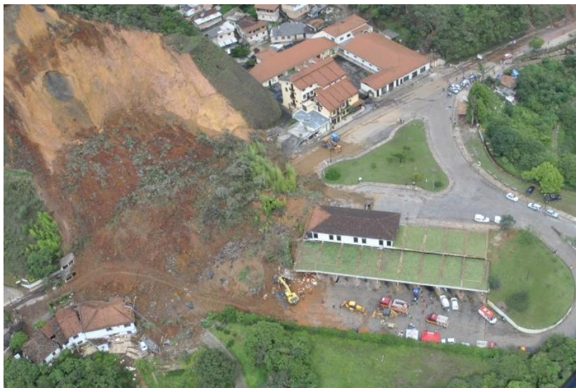
Figura 05: Desmoronamento de encosta próximo à Rodoviária de Ouro Preto – MG.
