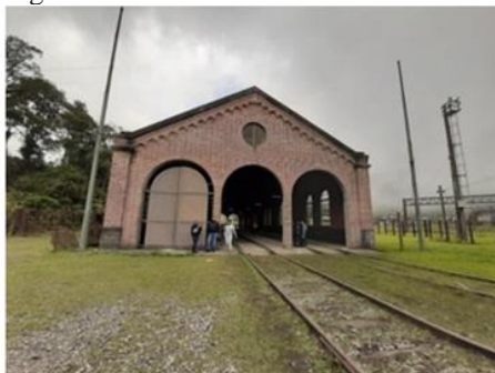
Figura 5: Vista externa do Pátio.
