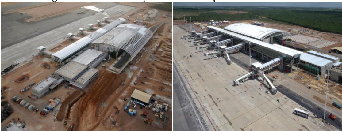
Figura 1 – Obra do Aeroporto de São Gonçalo do Amarante – RN
