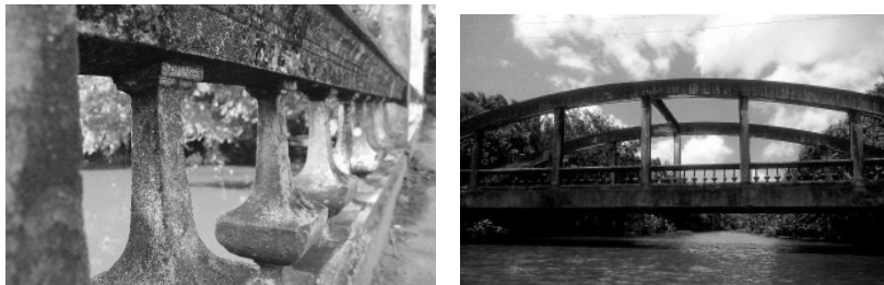
Figuras 1 e 2 – A Ponte dos Arcos, no Rio Gramame
