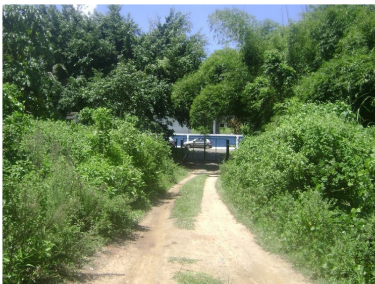
Figura 4 – Entrada para a Barragem do Rio dos Macacos
