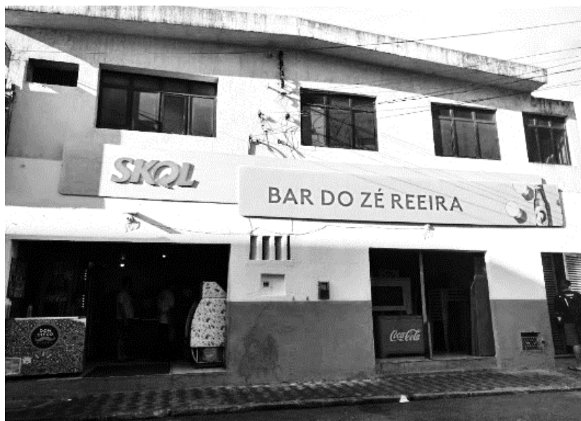
Figura 6 – Bar do Zé Reeira – fachada
