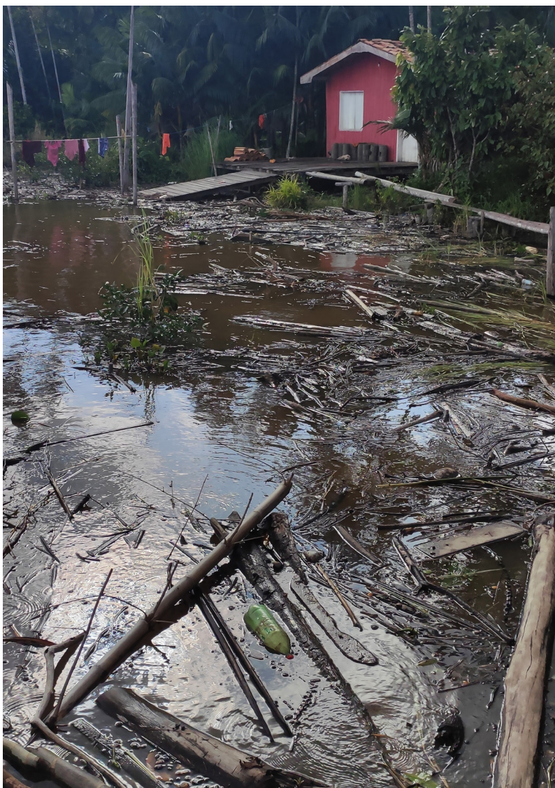
Figura 14 – Águas com resíduos sólidos diversos
