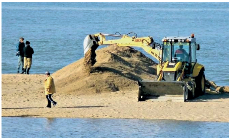
Figura 8 – Apertura de la barra con retroexcavadora (2011)
