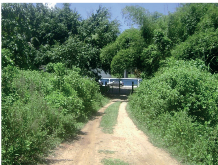
Figura 4 – Entrada para a Barragem do Rio dos Macacos
